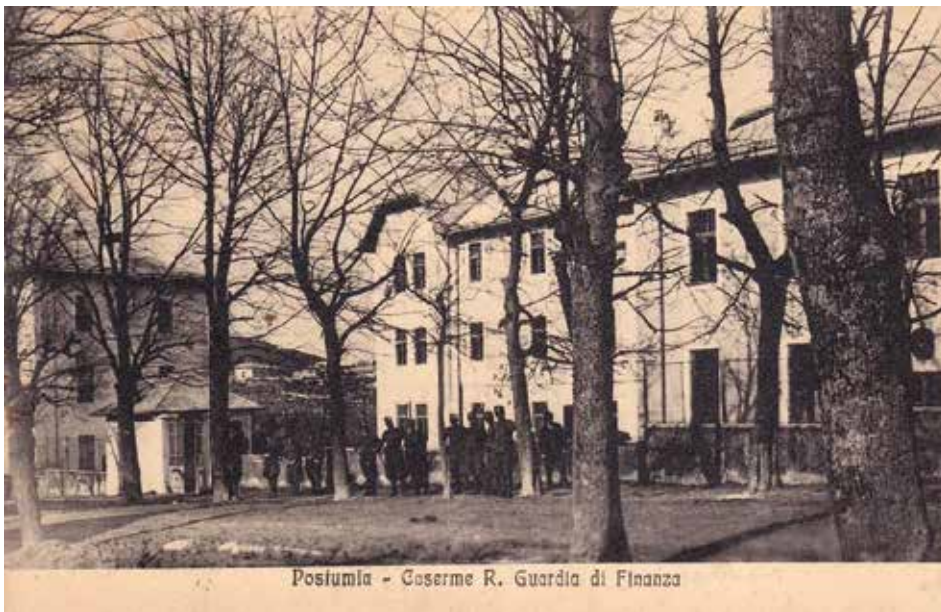
Stavba komande finančne straže v Postojni (↗ Ebay)
